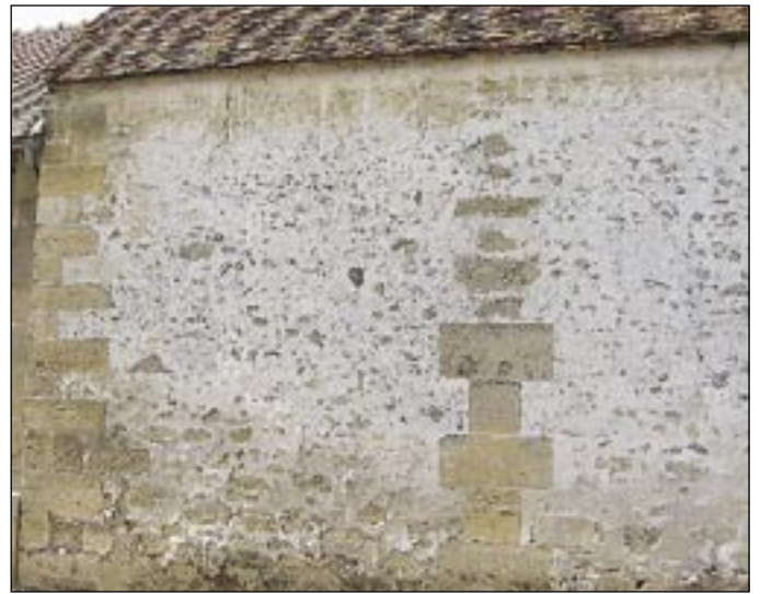
L'enduit à pierre vue vient mourir au raz des pierres de la chaîne qu'il ne doit pas recouvrir
