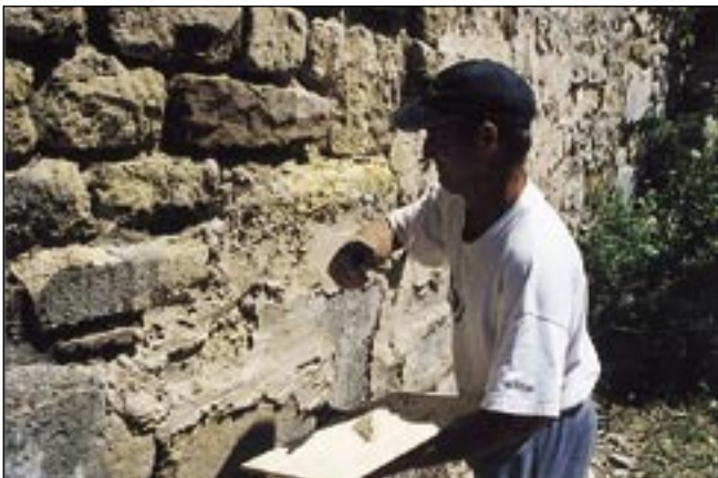
Application de la première couche d'un enduit à pierre vue
