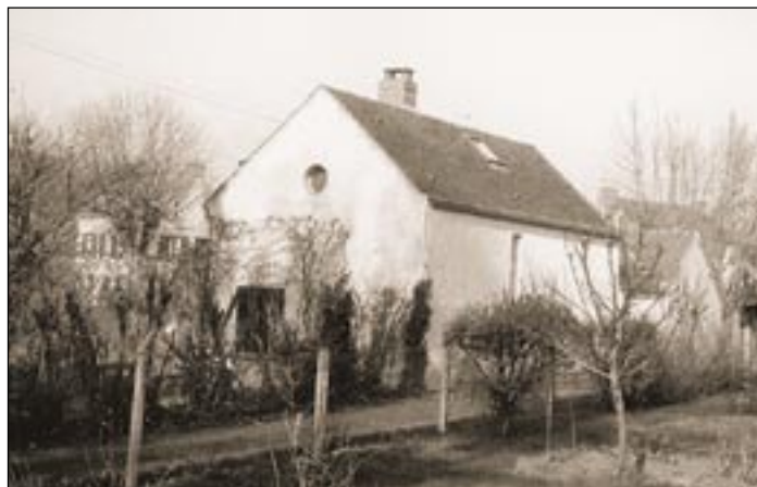
Construction récente en fond de parcelle de bon volume et bien intégrée
