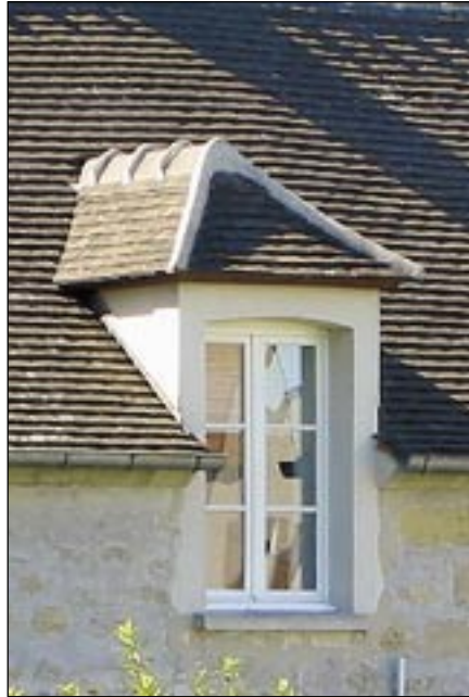
Lucame à la capucine, à trois versants, engagée dans le mur
