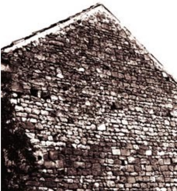
Moellons irréguliers. Construction en blocage de pierre
