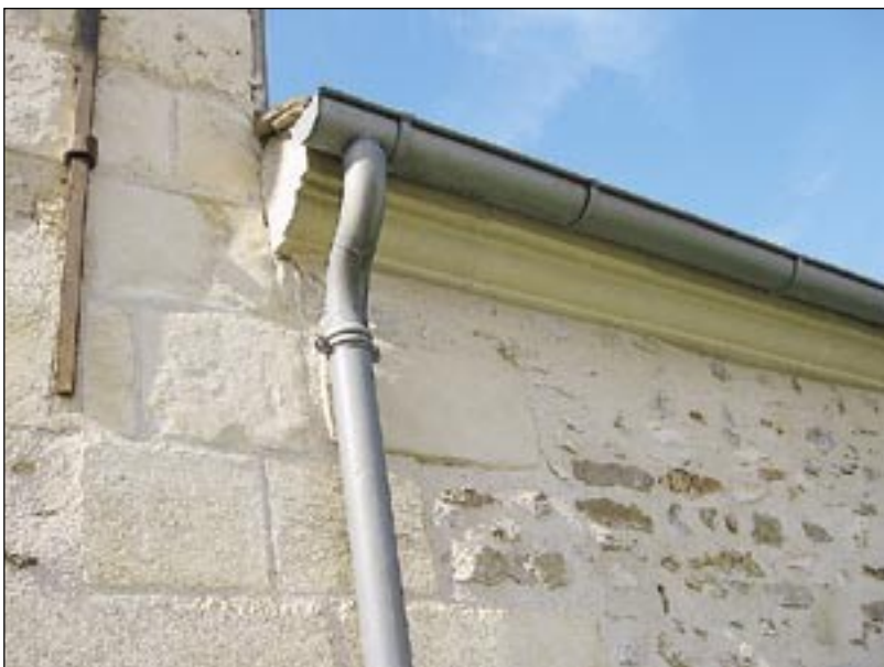
Discrète mise en valeur des corniches par un badigeon ocre
