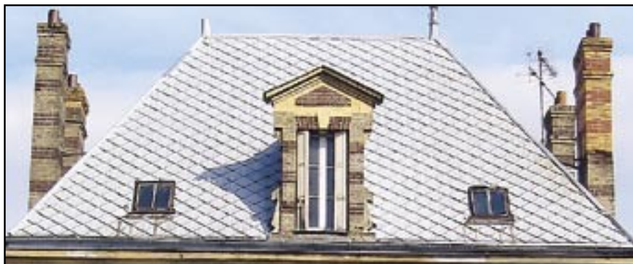
Belle toiture en zinc dont la découpe évoque l'ardoise
