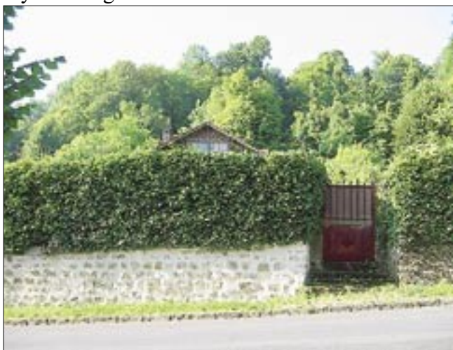
Mur bahut en moellons hourdis à la chaux surmonté d'une grille masquée par le lierre
