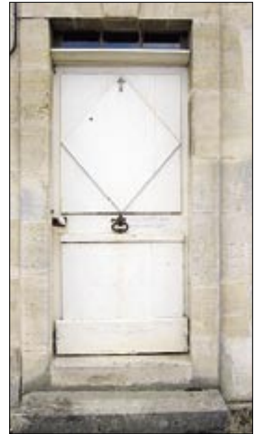
Porte pleine avec renfort d'une plinthe et imposte vitrée.
