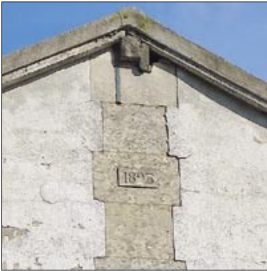
L'enduit à pierre vue vient mourir au raz des pierres de la chaîne qu'il ne doit pas recouvrir
