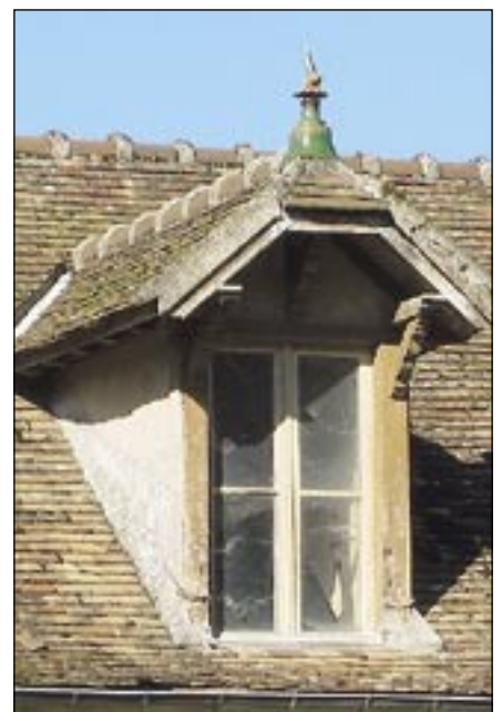
Le petit bout rabattu du toit devrait définir cette jolie lucame comme « à capucine ». Elle est cependant plus proche d'une « bâtière ». Le minuscule versant antérieur du toit semble là pour mettre en valeur un remarquable épi de faîtage.
