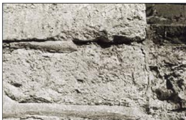
NON aux joints au ciment gris en relief
