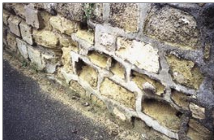
Mauvais enduit : en creux ou en relief les joints en ciment gris (ou blanc) sont à proscrire
