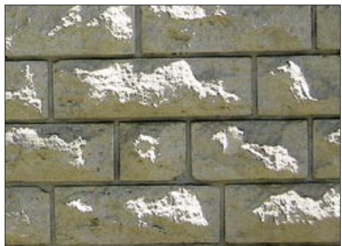
NON: mur pseudo-florentin en « bossettes » dans un village rural du Vexin. Inutile de risquer la comparaison avec le bâti traditionnel !
