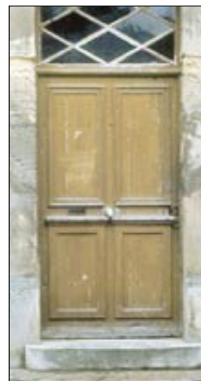
Porte de presbytère à panneaux moulurés, avec imposte
