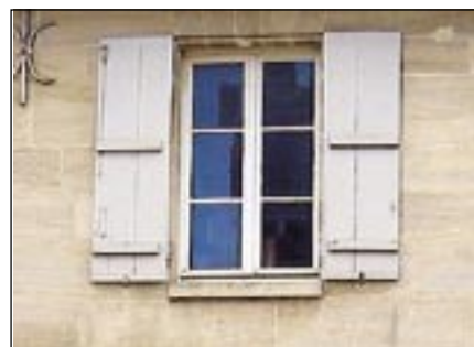
Fenêtre à 6 carreaux de bonne dimension (rapport 1,5/1) avec volets pleins à deux barres
