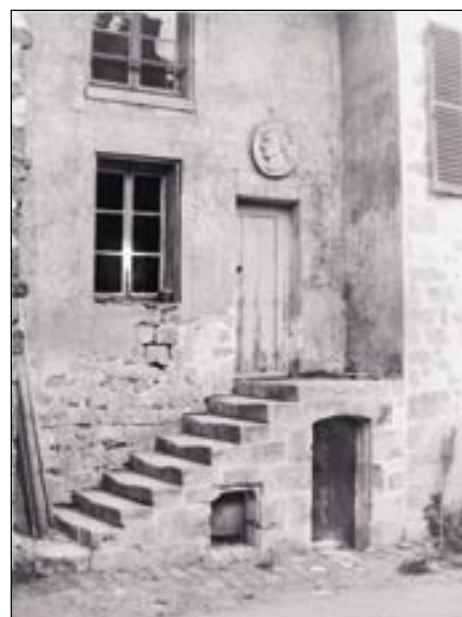
Porte d'accès en étage extérieur. Cette disposition est fréquente dans les maisons rurales
