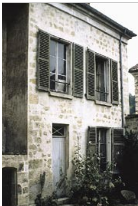
Volets partiellement persiennés en rez-de-chaussée. Volets d'étage entièrement persiennés. Fenêtres à six carreaux
