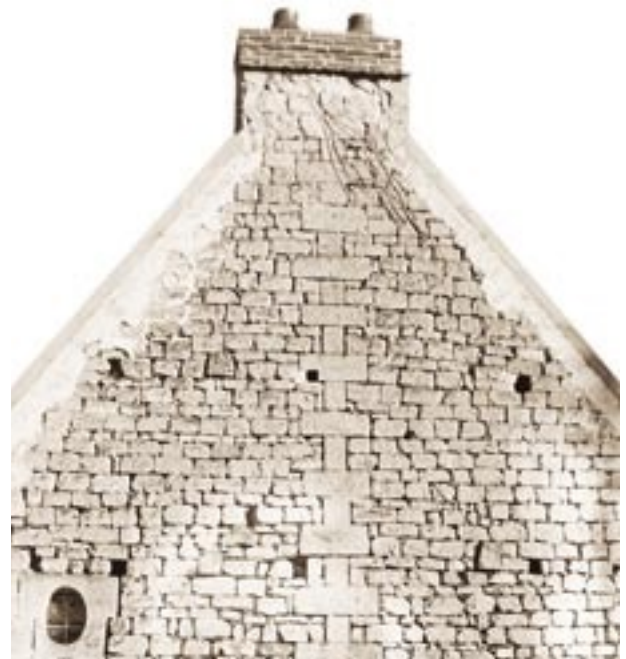
Pignon en moellons taillés, assisés horizontalement (à joints secs). Chaîne de pignon en pierre de taille, solins en plâtre
