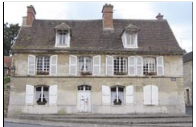
Fenêtres à 24 carreaux acceptables sur cette façade classique d'inspiration urbaine. Les fenêtres à 6 carreaux du rez-de-chaussée sont discrètes et mieux intégrées. Elles attirent moins l'attention
