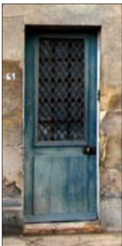
OUI à cette porte d'entrée vitrée protégée par une grille en fonte.
