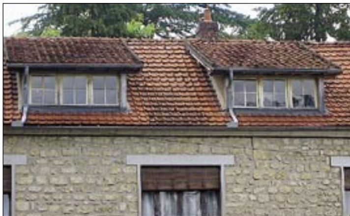
Chiens-assis et fenêtres de largeur excessive. Encadrement des fenêtres trop marqués. Joints en ciment gris à proscrire
