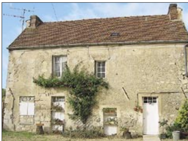
Cet ancien presbytère est une très belle maison rurale fin XVIII e siècle
