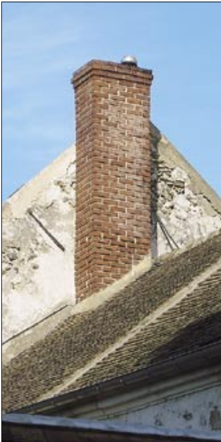
Cheminée en brique accolée à un mur mitoyen
