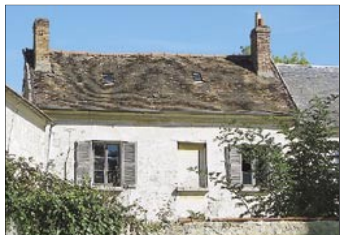
Maison enduite au plâtre avec fenêtre aveugle en façade
