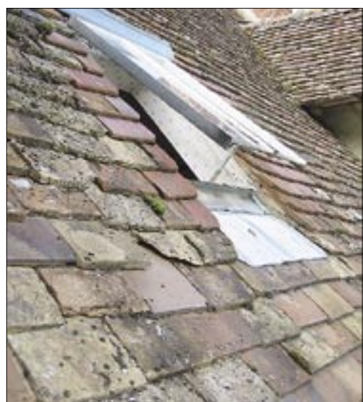
Tabatière avec peu de relief, tuiles plates sans uniformité, en haut à droite noue fermée entre toit et lucarne
