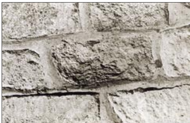
NON aux joints au ciment gris en creux
