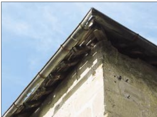
Les gouttières seront soigneusement réparées et entretenues.
