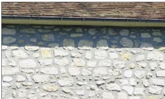
Mauvais enduit : en creux ou en relief les joints en ciment gris (ou blanc) sont à proscrire
