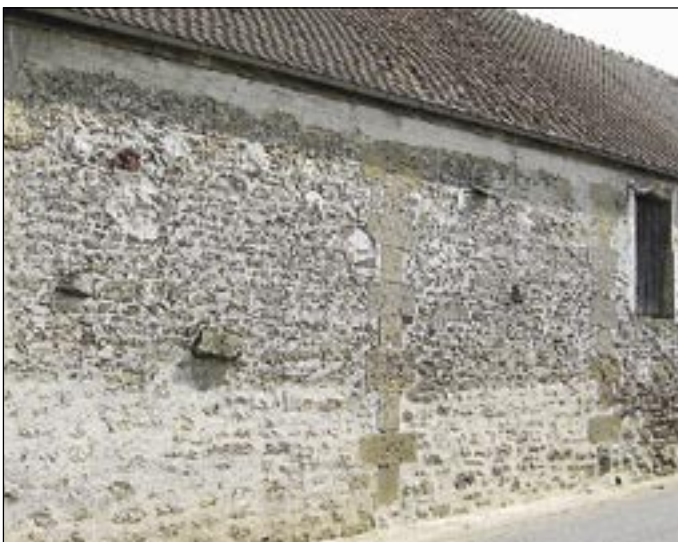
L'enduit à pierre vue vient mourir au raz des pierres de la chaîne qu'il ne doit pas recouvrir
