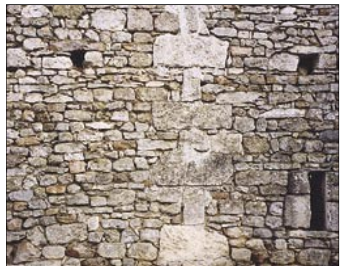
L'enduit à pierre vue vient mourir au raz des pierres de la chaîne qu'il ne doit pas recouvrir
