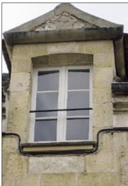
Lucarne en pierre de taille à deux pentes dite en « bâtière », à linteau cintré, engagée dans le mur de façade.
