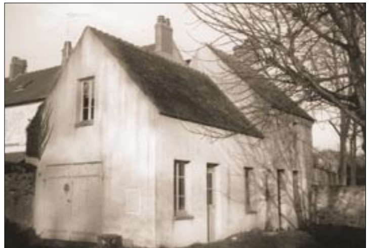
Garage annexé à une petite maison ancienne Dans le respect du caractère rural de l'ensemble
