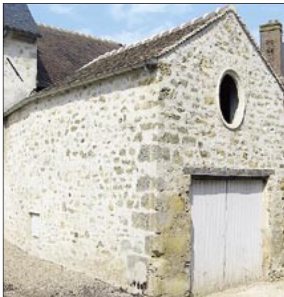
Bon enduit : joints largement beurrés. L'œil-de-bœuf est un peu trop grand
