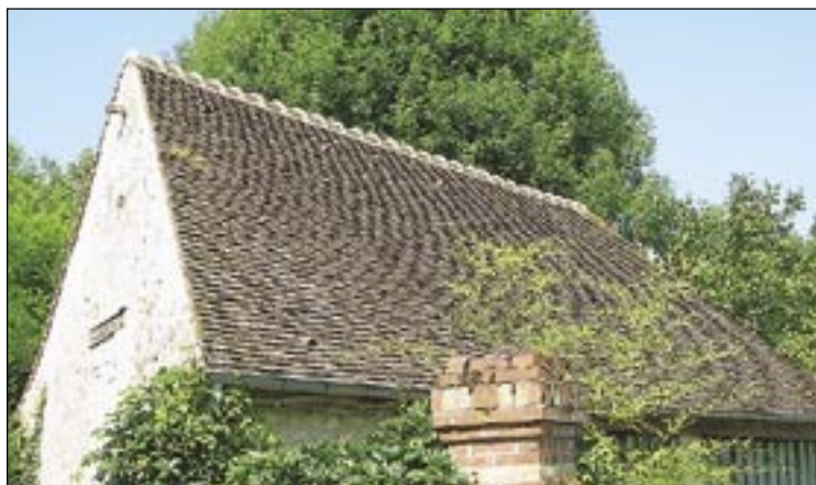
Belle restauration en tuiles plates.
