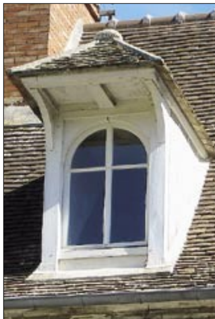
Lucame fenêtré fenièr* en retrait sur la toiture. Une poulie sous l'avancée du toit servait à monter les denrées
