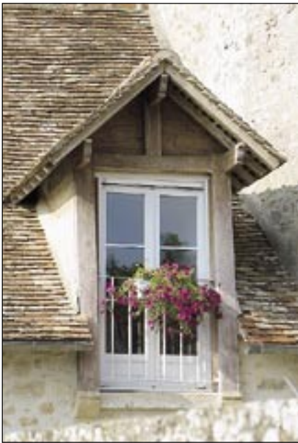
Lucame porte, fenièr*, à l'aplomb du mur de façade, transformée en fenê- tre. Sa toiture à deux versants la définit comme « lucame en bâtière »
