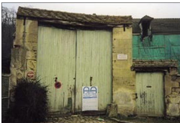
La référence du permis et les précisions sur la nature des travaux en cours doivent être signalées par un affichage lisible depuis la voie publique
