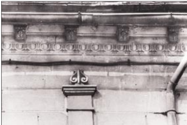
Façade de maison de bourg en pierre de taille. Modénature recherchée, pilastre, frise, moulure, modillons supportant la corniche.
