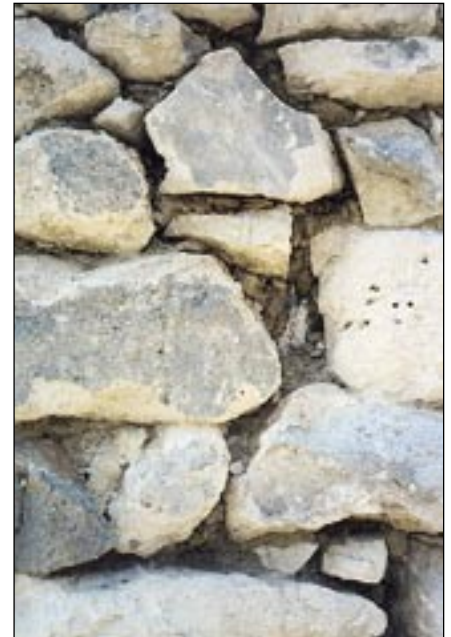
Mur en moellons liés à la terre « mortier d'hirondelle »
