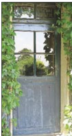
Porte vitrée à 4 carreaux
