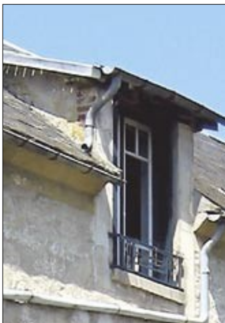
Lucarne rampante engagée dans le mur gouttereau. La gouttière ne barre pas l'ouverture
