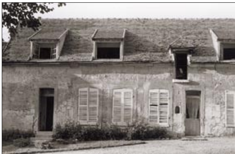
Même recouverts en tuiles plates, ces chiens-assis trop larges sont disgracieux comparés à leur voisine, la lucarne « à la capucine ».
