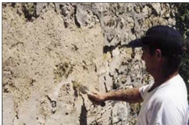
Deuxième couche d'enduit à pierre vue. remplissage des joints au nu du mur serré à la truelle
